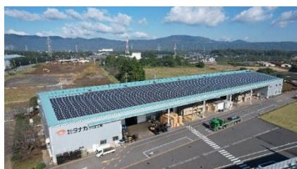
住宅資材部門つくば工場
