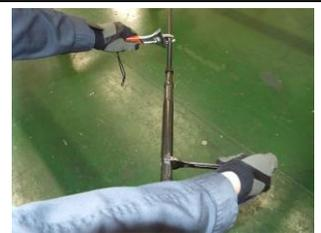
\* 「ターンバックル胴」の締め付けトルクは「10N・m」を推奨とし、ねじ山が壊れるまたは金物に変形するまで締め付けをしないでください。
