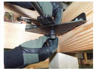
「ブレース用羽子板」は「端部金物」の内側に合わせてセットします。
