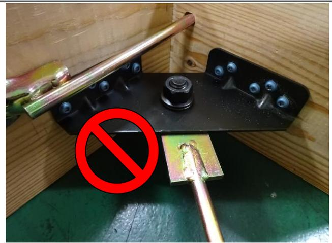
「ブレース用羽子板」が「端部金物」の外側にセット×
