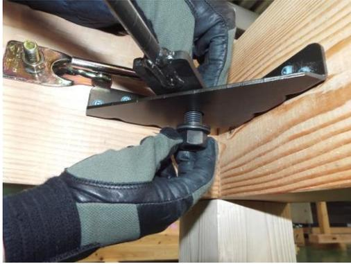
⑦ 鋼製ブレースの両端の「六角ナット M16」をモンキーレンチで締め付けます。
