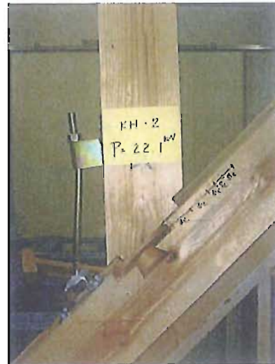
写真-2 破壊状況 番号：2 最高載荷荷重：22.1kN 支持梁の割れ及びほぞの外れ後、金物及びM座金の変形進展
