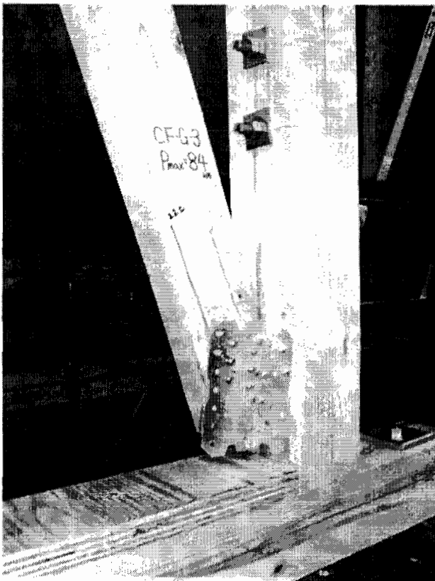
写真-4 破壊状況
